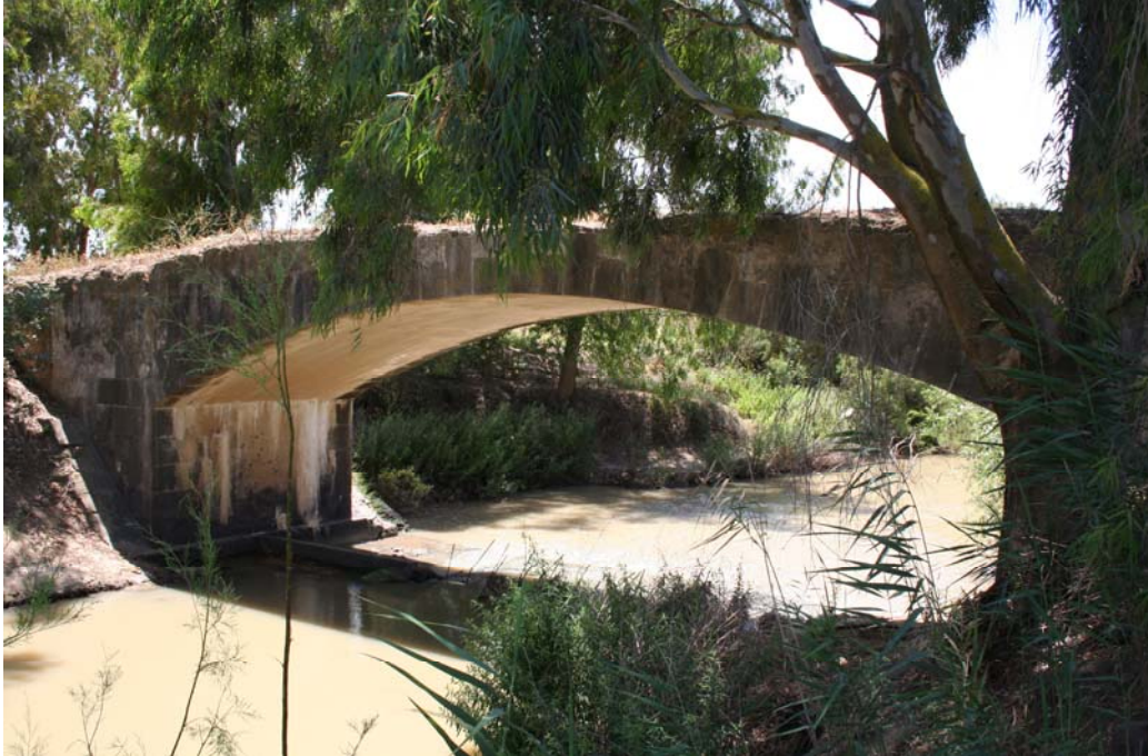
Foto 2.- Puente de San Fernando (s.XIX)
